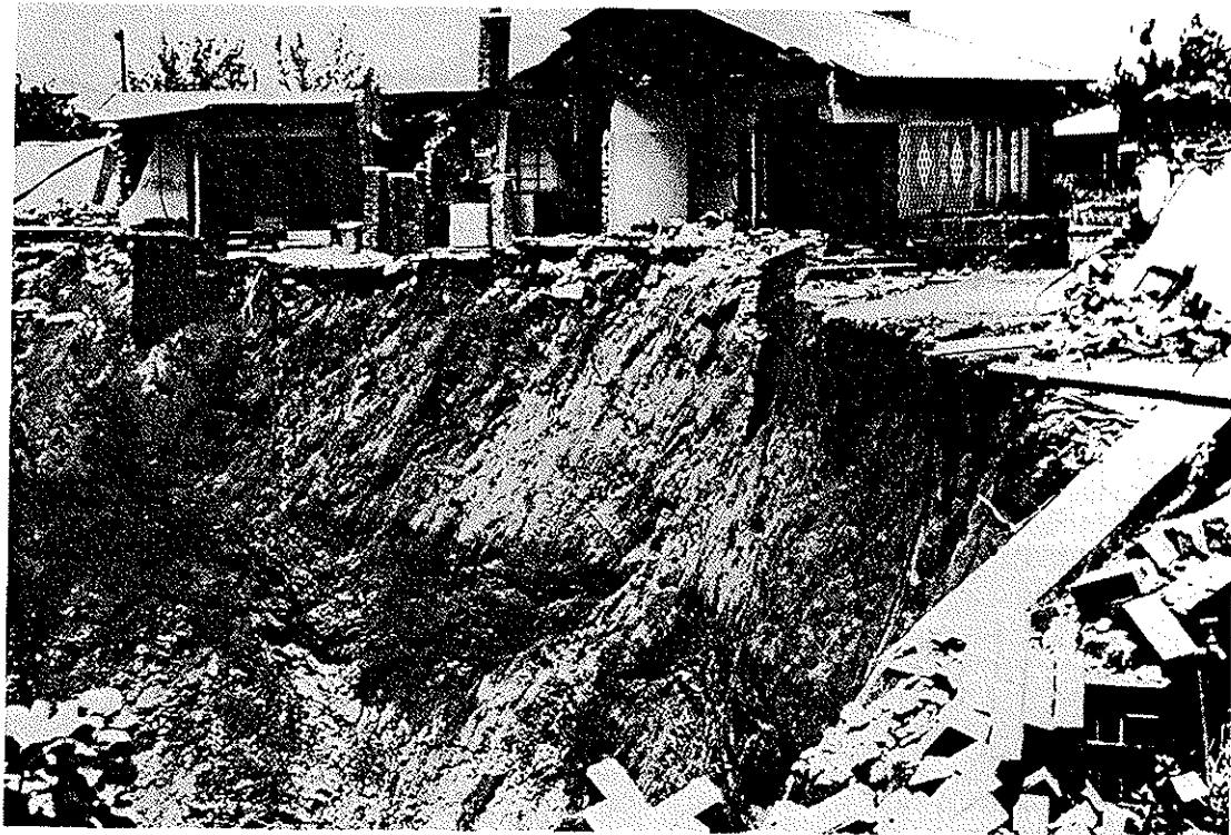
Pl. 5.2 — Sinkhole at Blyvooruitzicht (with acknowledgement to IAHS Publication 89, Pl. 2). Sinkgat by Blyvooruitzicht (met erkenning aan IAHS-publikasie 89, Pl. 2).
